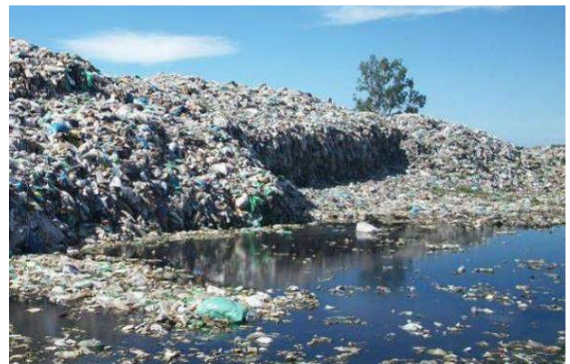
Disposición directa en suelo, sin impermeabilización
