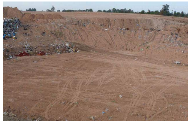
Impermeabilización con arcilla
