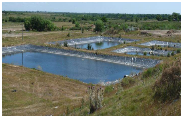
Disposición directa en suelo, sin impermeabilización
